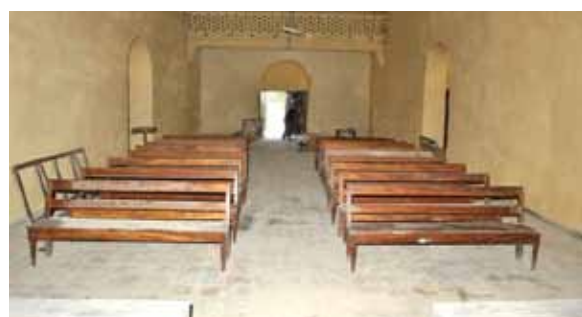
Interiér kostela při probíhající opravě.
