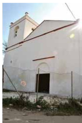
Exteriér kostela po opravě.
