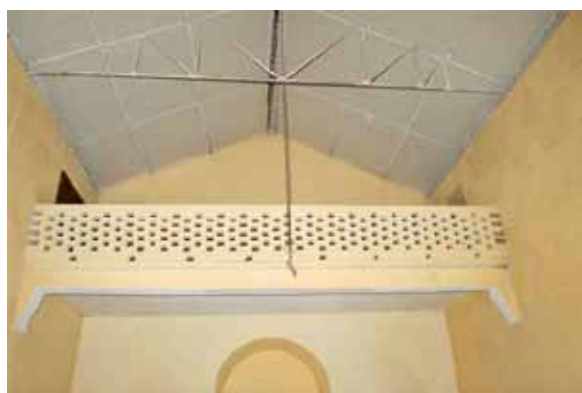
Opravený interiér kostela.
