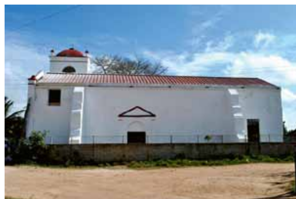
Kostel po opravě v roce 2016.
