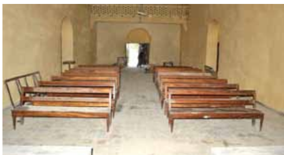
Interiér kostela při probíhající opravě.
