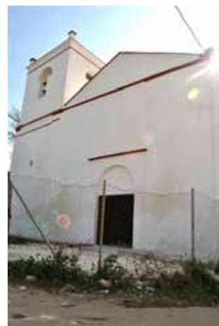
Exteriér kostela po opravě.
