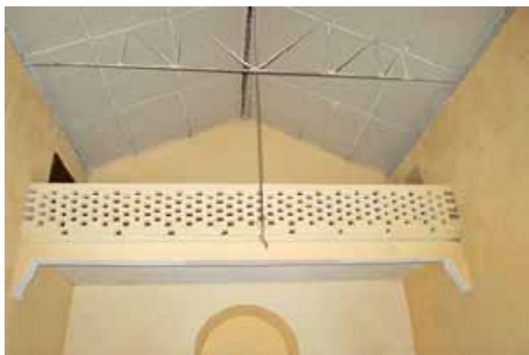
Opravený interiér kostela.
