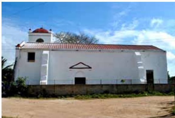
Kostel po opravě v roce 2016.
